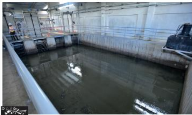
A estas piscinas llegan las aguas para ser procesadas. En ellas comienza el proceso con el estancamiento de sedimentos y la basura más gruesa.
